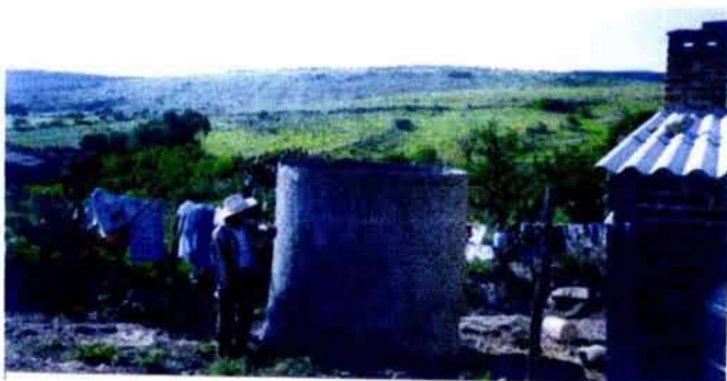
Foto 3. Tanque de depósito.
